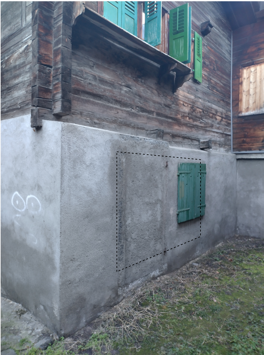
Foto der Nord-West-Seite mit den gut sichtbaren Hinweisen auf die alte Türe und das Fenster. Die gestrichelte Linie stellt den Umriss des geplanten neuen Fensters dar.
